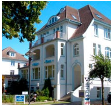
Das Hotel Polar-Stern im Ostseebad Kühlungsborn wurde mit JADO Lighthouse-Armaturen ausgestattet.
